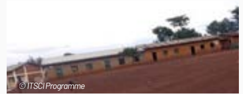
École Fondamentale de Tura
